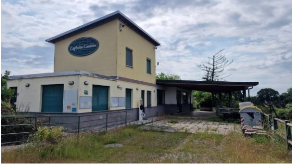
Figura 5 - Vista di insieme fabbricato principale
