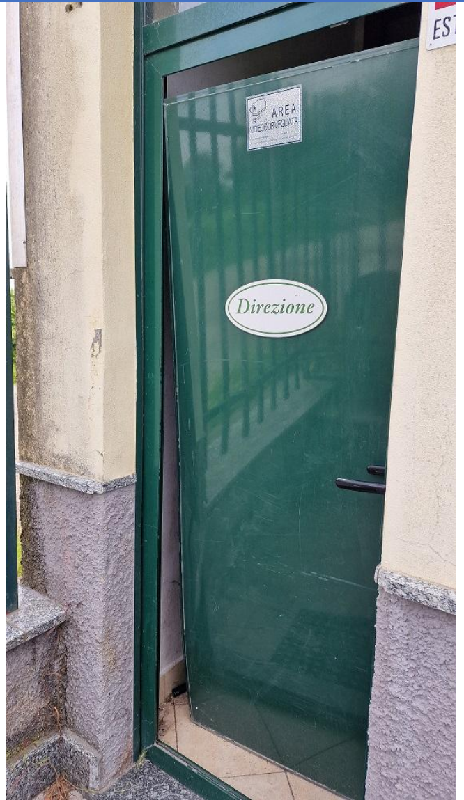
Figura 6 - Porta di accesso all'Ufficio di Direzione
