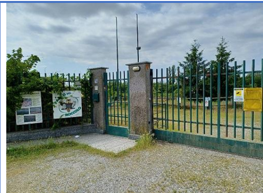
Figura 2 - Dettaglio ingresso principale - cancelli elettrificati carraio e pedonale
