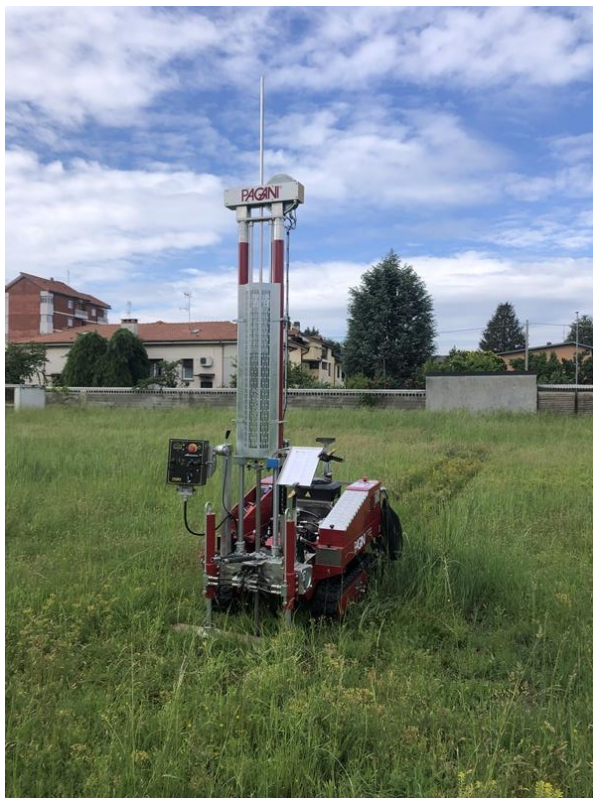
Foto 2: Esecuzione Prova Penetrometrica n.2
