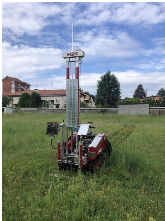
Foto 2: Esecuzione Prova Penetrometrica n.2
