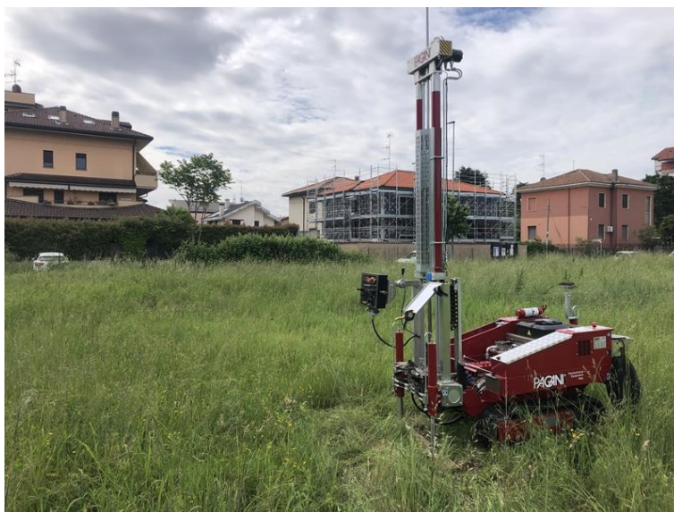
Foto 4: Esecuzione Prova Penetrometrica n.4
