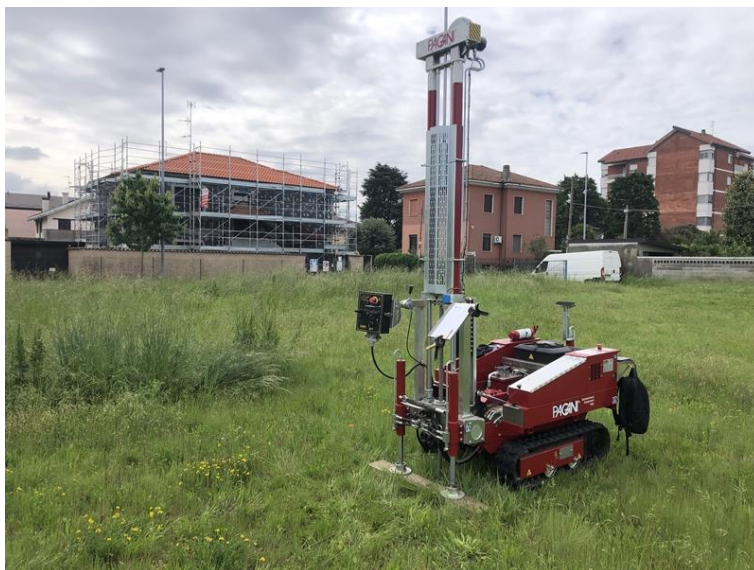
Foto 5: Esecuzione Prova Penetrometrica n.5
