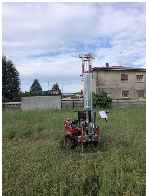
Foto 1: Esecuzione Prova Penetrometrica n.1
