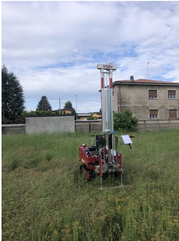
Foto 1: Esecuzione Prova Penetrometrica n.1
