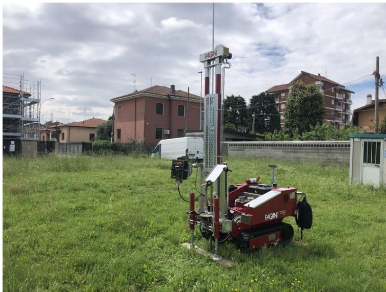
Foto 6: Esecuzione Prova Penetrometrica n.6
