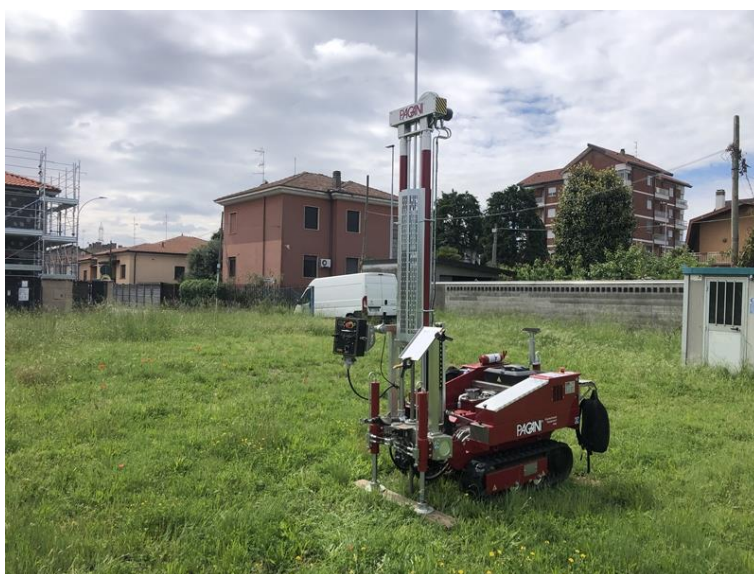
Foto 6: Esecuzione Prova Penetrometrica n.6
