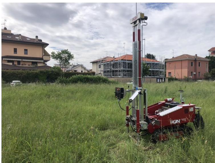
Foto 4: Esecuzione Prova Penetrometrica n.4
