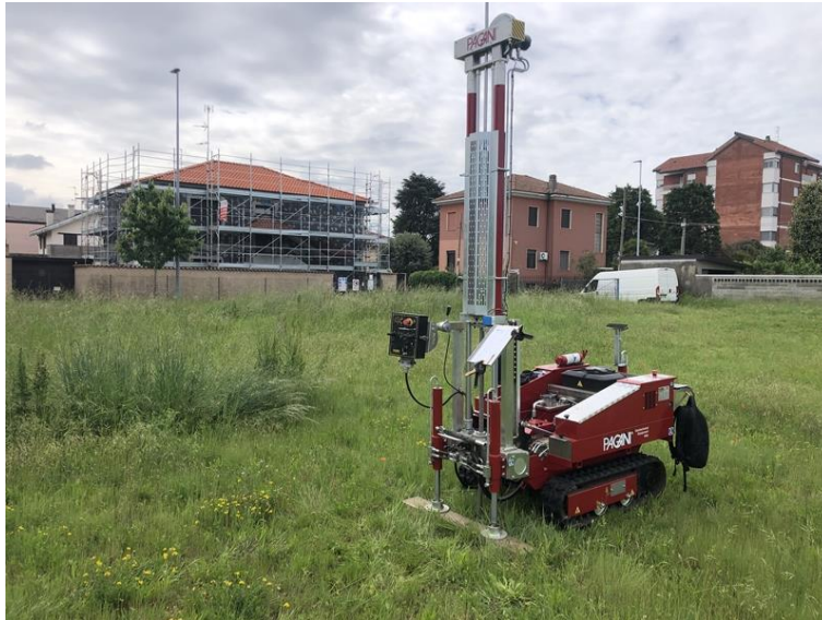
Foto 5: Esecuzione Prova Penetrometrica n.5
