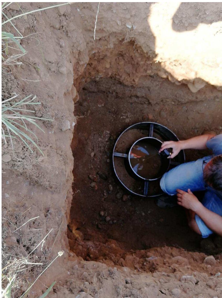
Figura 9 – Fasi esecutive prove di permeabilità.
