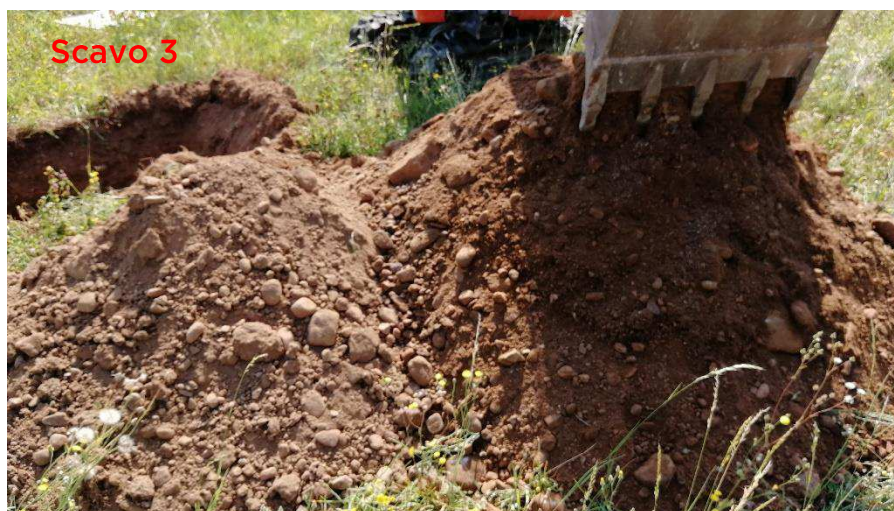
Figura 8 – Particolare del primo sottosuolo nei tre scavi eseguiti.
